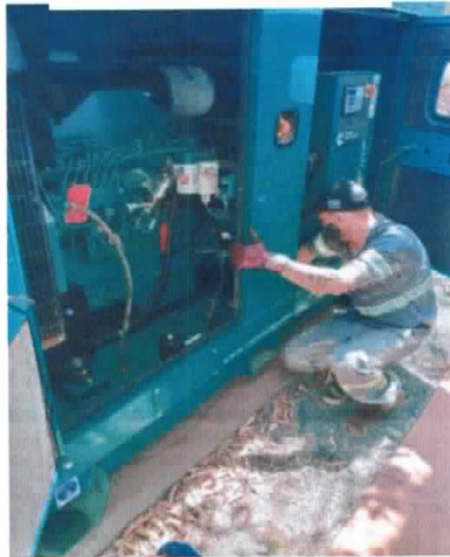
Figura 2. Manutenção corretiva do gerador
