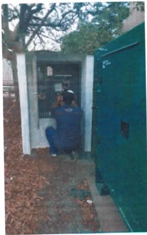
Figura 8. Manutenção Preventiva Gerador
